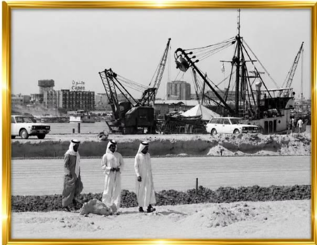
ميناء راشد في بدايات إنشائه، أحد المشاريع الاستراتيجية التي أسهمت في تطوير البنية التحتية وتعزيز مكانة الإمارات كمركز تجاري وبحري.
